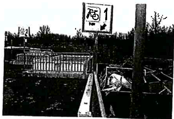
Quai de dépôt - déchetterie de Caussade
